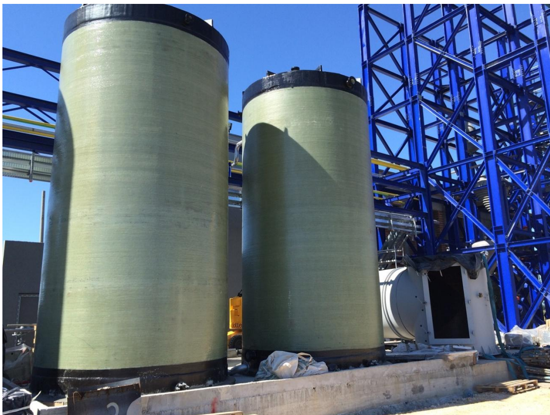
Vista tanques de acumulación de agua osmotizada y agua de proceso
