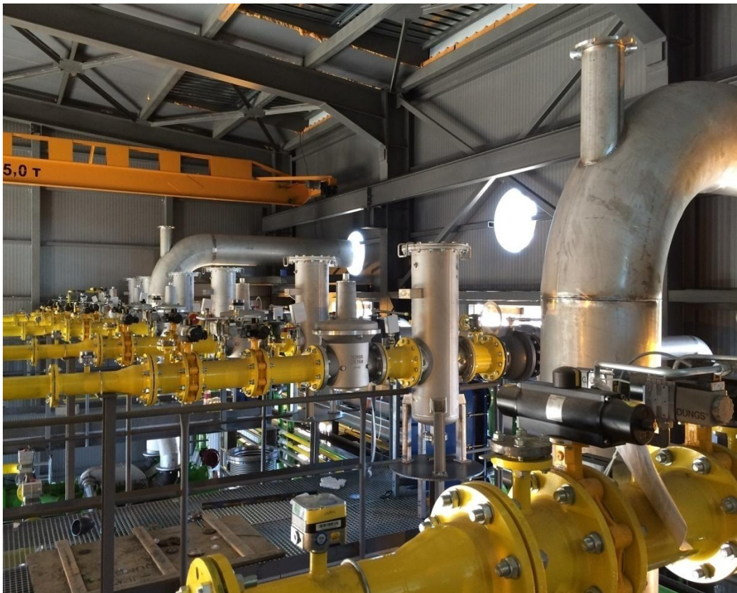
Detalles de las rampas de syngas de los motogeneradores GE Jenbacher
