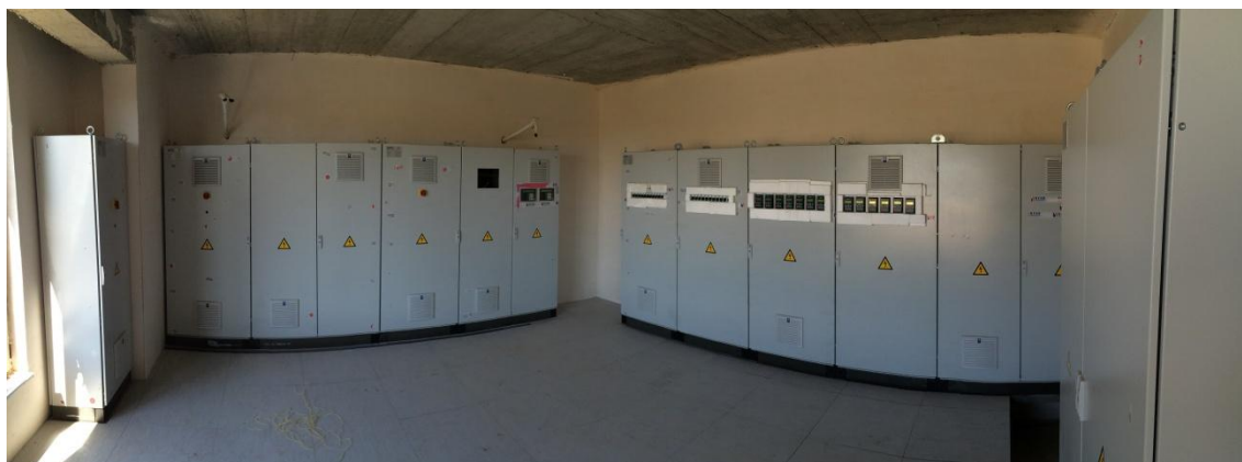
Cuadros eléctricos planta de gasificación
