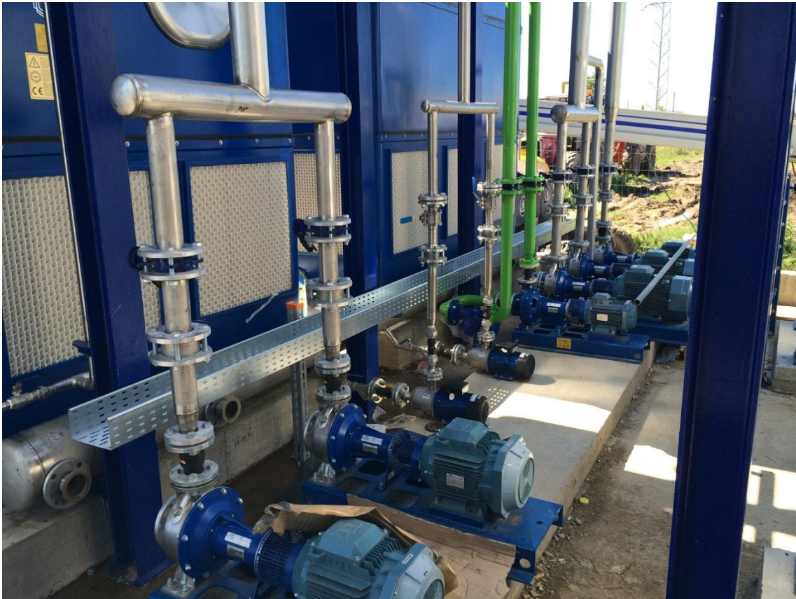
Vista Torres de Refrigeración y bombas del sistema de refrigeración de la planta de generación de electricidad.
