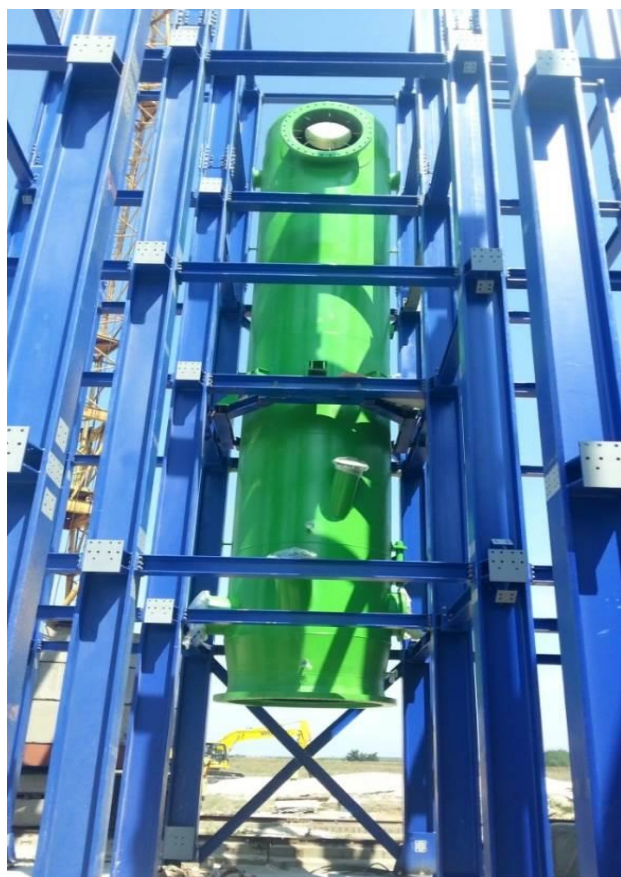
Vista detallada de Gasificador de lecho fluido burbujeante de 2310 Kg/h.
