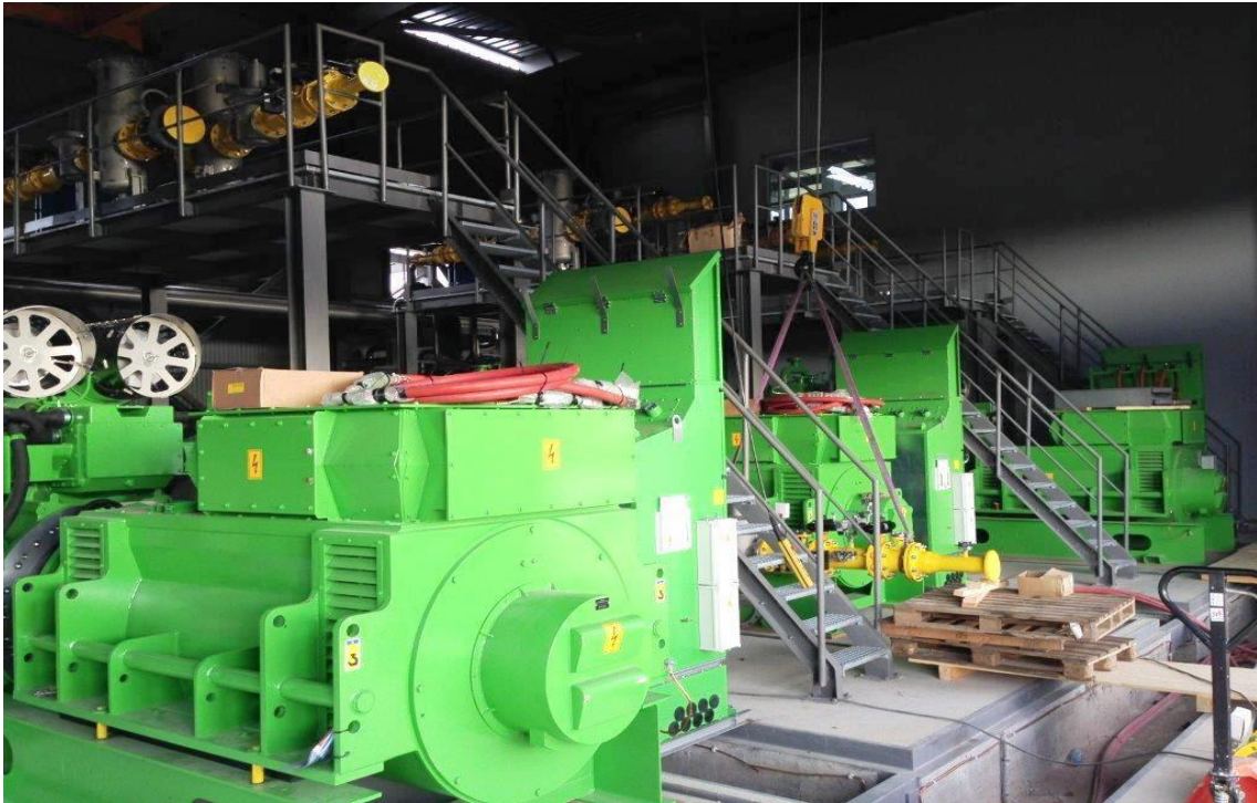
Otro detalle interior sala de motogeneradores GE Jenbacher
