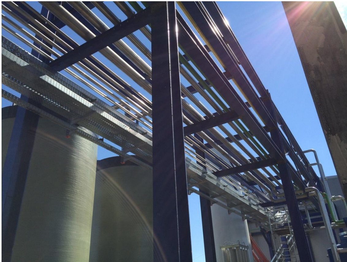
Otra vista rack exterior para la soportación de la instalación mecánica y eléctrica.
