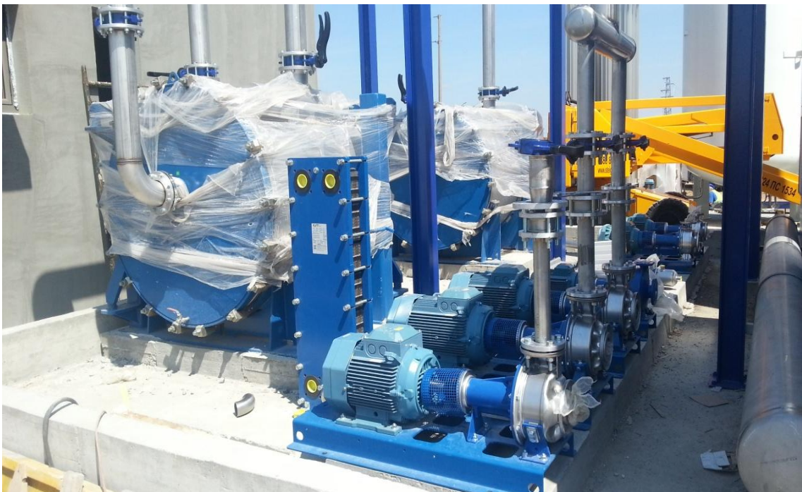
Bombas e intercambiadores del sistema de refrigeración de la planta de generación de electricidad
