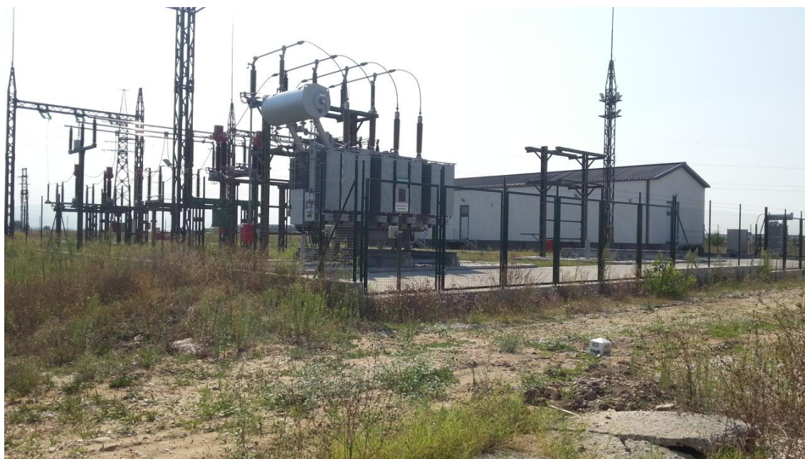
Subestación eléctrica de EVN donde se exporta la energía eléctrica que produce la planta
