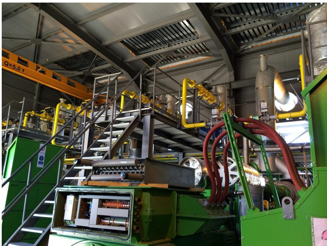
Otra vista ampliada de los motogeneradores GE Jenbacher en fase de montaje
