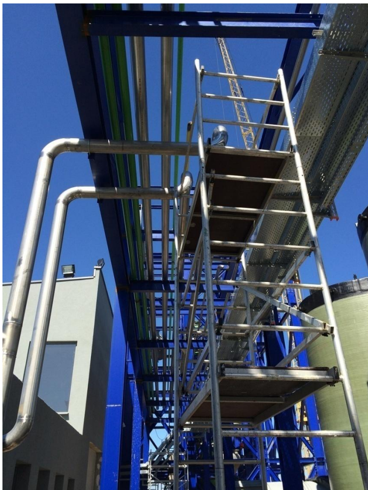
Vista rack exterior para la soportación de la instalación mecánica y eléctrica.
